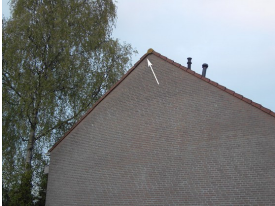
Fig. 33 Gierzwaluwnestingang onder de daknok
