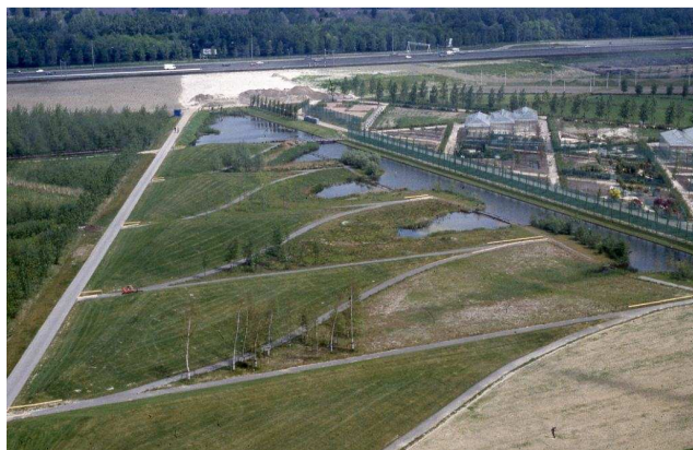
Fig. 38 Poldertuinen direct na de aanleg
