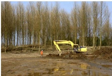
Het graven van de vogelplas (de ijzerrijke kwel is duidelijk zichtbaar) (Johan Vos)
