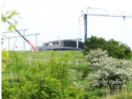
De bouw aan de skibaan vordert (Fred Reeder)
