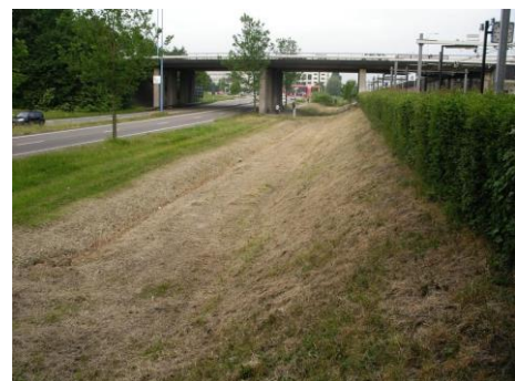
Talud spoorlijn, beeld na het klepelen in mei 2011 (Johan vos)
